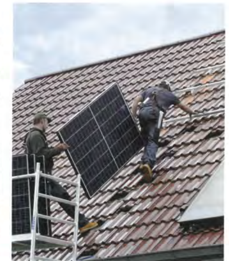
Zunächst wurde das Dach mit der Unterkonstruktion für die Anlage vorbereitet. Die Solarmodule kamen bereits zwei Tage vorab per DHL. Die Montage der kompletten Anlage erfolgte dann an einem einzigen Tag innerhalb von nur fünf Stunden.
